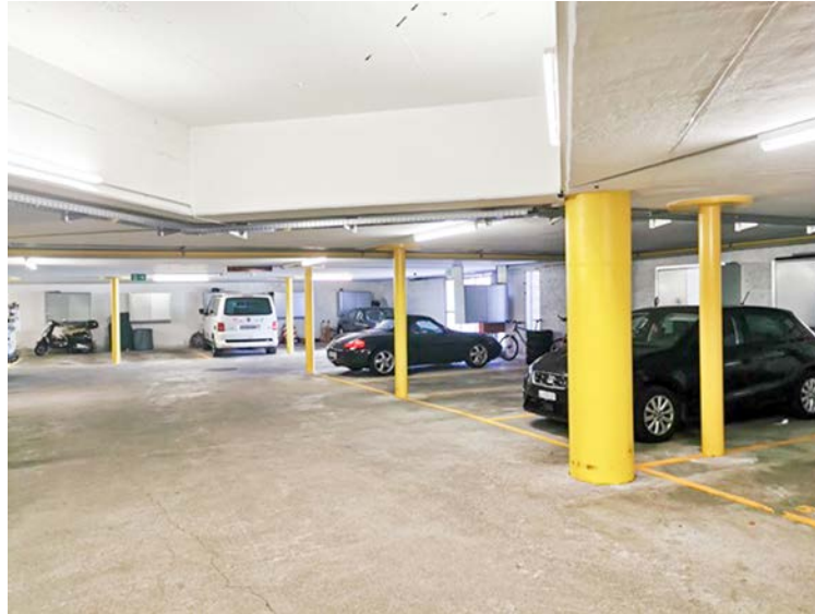
Bestehendes Kabeltrasse in der Tiefgarage
